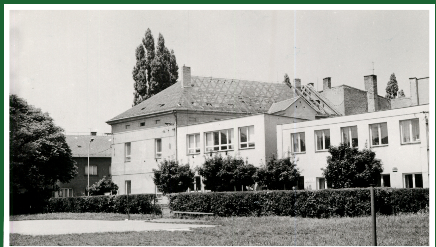
Rekonstrukce budovy v ulici Dobrovolského čp. 4
